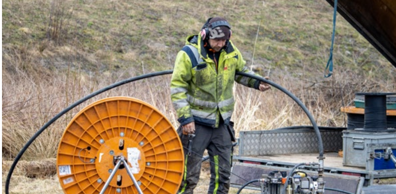
Vid en fiberblåsning matas fiberkabeln med hjälp av tryckluft genom nedgrävda slangar mellan kopplingskåpen.
