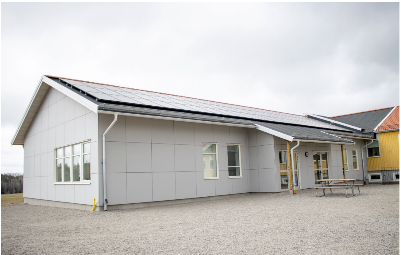
Som en del i renoveringen av Hedekas skola har bland annat två nya klassrum byggts till, maj 2022 – Foto: Erland Pålsson
