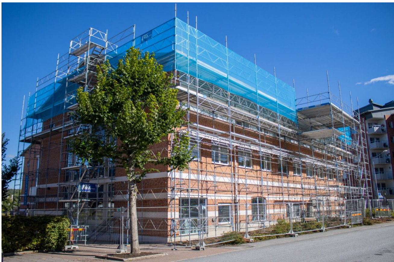
Under året påbörjades byte av tak och installation av solceller på kommunhuset – Foto: Erland Pållsson
