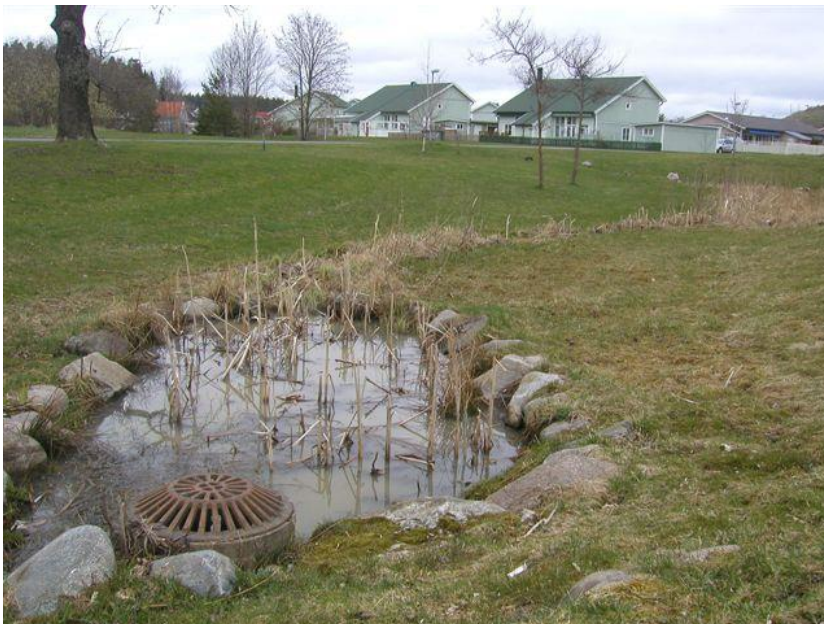
Figur 11 Diket är försett med upphöjd kupolbrunn vid utflödet samt meandrande utformning för fördröjande effekt.
