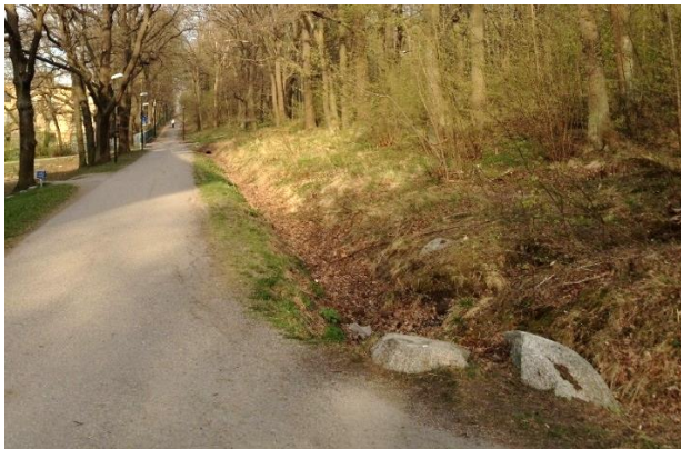
Figur 9 Avskärande dike kan anläggas vid fastighetsgräns för att förhindra att naturmarkens ytliga vatten rinner in på fastigheterna.
