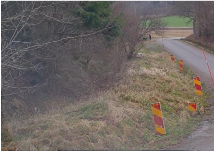
Figur 10 Trolig dagvattenanläggning längs med Bergsviksvägen i Västra området.
