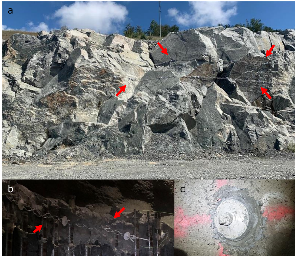
Figur 5. Exempelbilder på installerade bergbult och fjällband (se röda pilar). a) Bergskärning med installerade fjällband som förankras med bergbult och stabiliserar en potentiellt instabil bergskärning med stora block. b) Förstorad bild över fjällband, se röda pilar. Fjällband utgörs av band i stål, som är förankrade med bergbult. c) Förstorad bild på en installerad korrosionsskyddad bergbult med bricka, halvkula och mutter.
