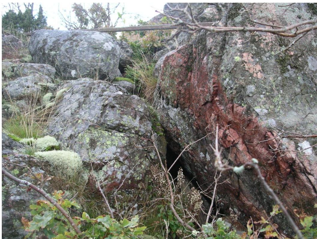
Spricka i berget vid platsen för servicebyggnad
