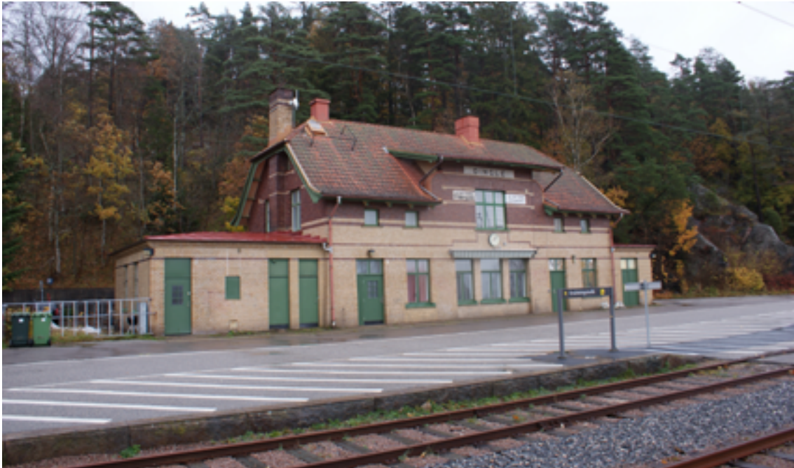
Dingle stationshus, byggt 1903, tillbyggt på 1930-talet. Foto: Cecilia Wingård, Bohusläns museum.
