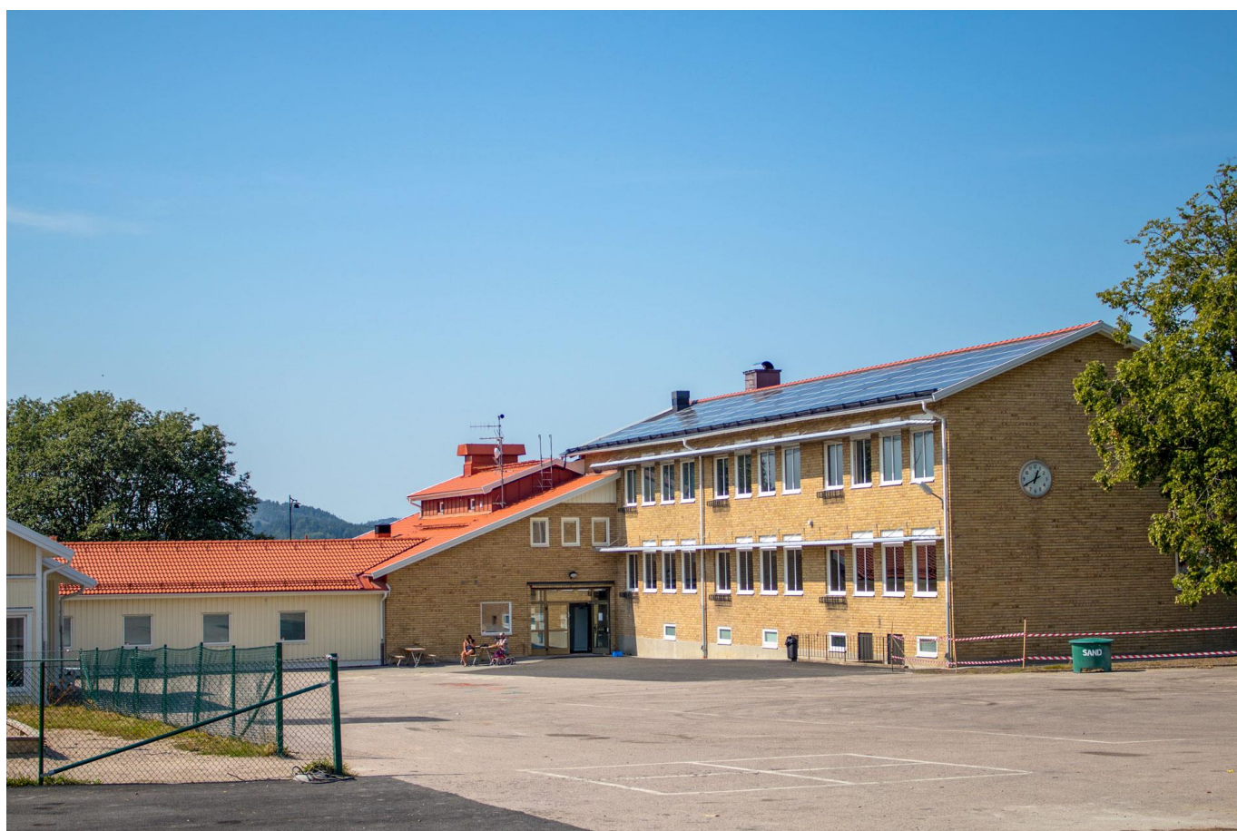
Centrumskolan i Dingle
