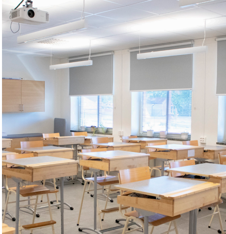
Klassrum med ny belysning, ventilation, ytskikt och ljuddämpning
