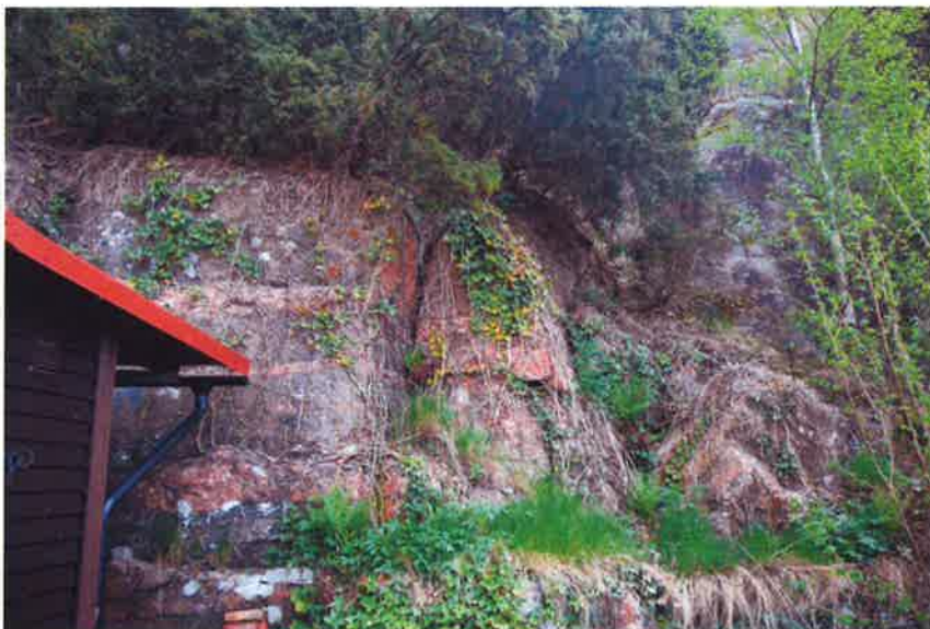
Figur 17. Lösgjort block om ca 1*0,5 m vilandes på svagt inåtlutande avsats 2 m över markytan intill bostad på fastighet 3:14. Ligger troligtvis stabilt idag, men kan genom rotsprängning, alternativt frostsprängning leda till instabilitet (Foto ID=16).
