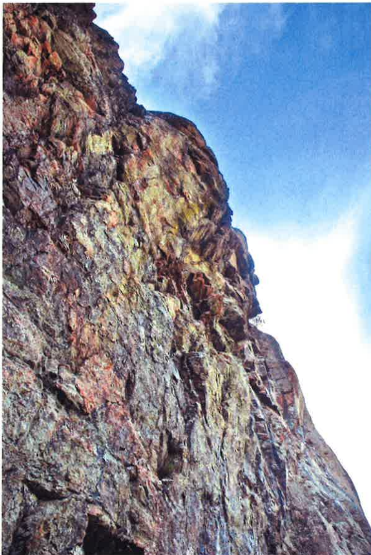
Figur 15. Berget intill fastighet 3:43 är mycket brant och uppsprucket (Foto ID=73).
