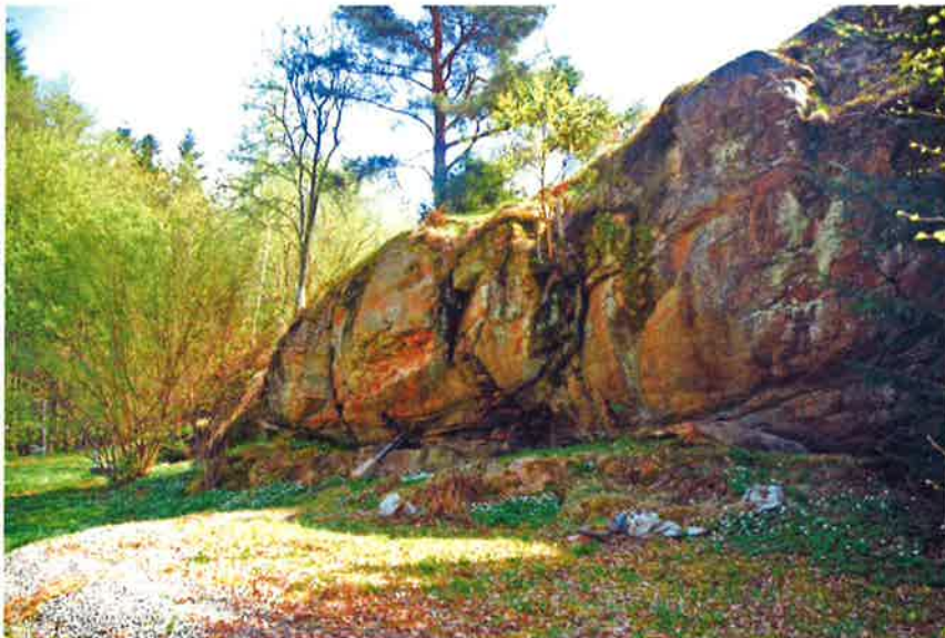
Figur 24. Block i en ca 4 m hög bergslänt med överhäng, på fastighet 3:29. Frostsprängning eller rotsprängning i de brantstående sprickplanen kan leda till instabilitet och blocknedfall. Vy mot öster (Foto ID=89) (Se även foto ID= 88 i bilaga 2).
