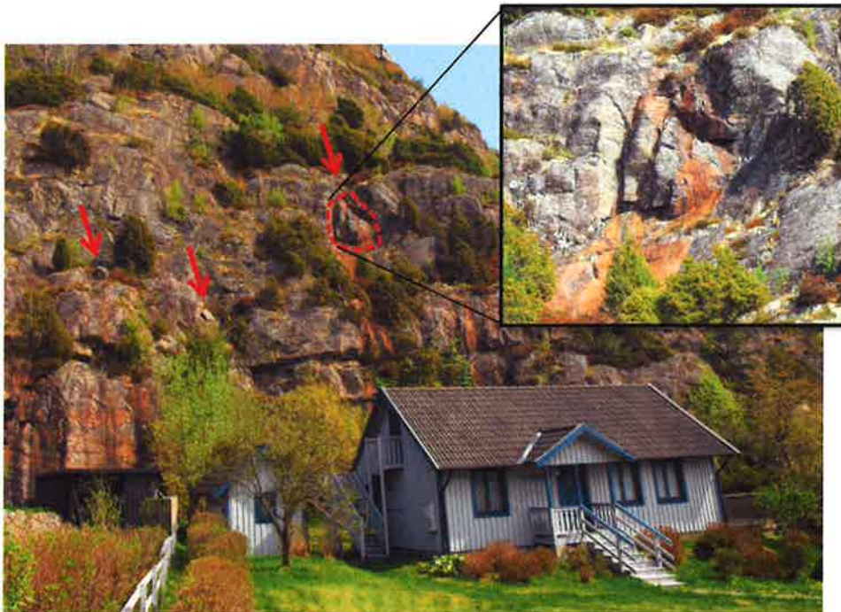
Figur 19. Fastighet 3:2. Två mindre (vänster i bilden), löst liggande block ca 5 m upp i slänten utgör risk för blocknedfall. Ett större block ca 9 m upp i slänten kan utgöra risk för blocknedfall då sprickytorna tycks vara vattenförande (rostfärgade beläggningar). Vy mot sydost (Foto ID=28 och 31) (Se även foto ID=30 i Bilaga 2).
