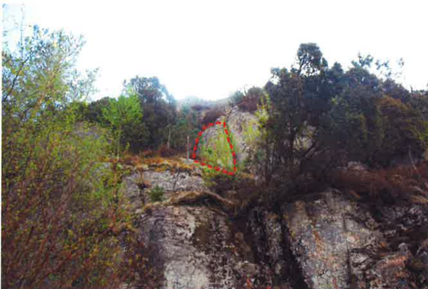
Figur 21. Fastighet 3:32. Lösgjort block vilandes på avsats, ca 5 m upp. Oklar blocksäkerhet, men utgör i dagsläget troligtvis ingen risk för blocknedfall. Vy mot sydost (Foto ID=61).
