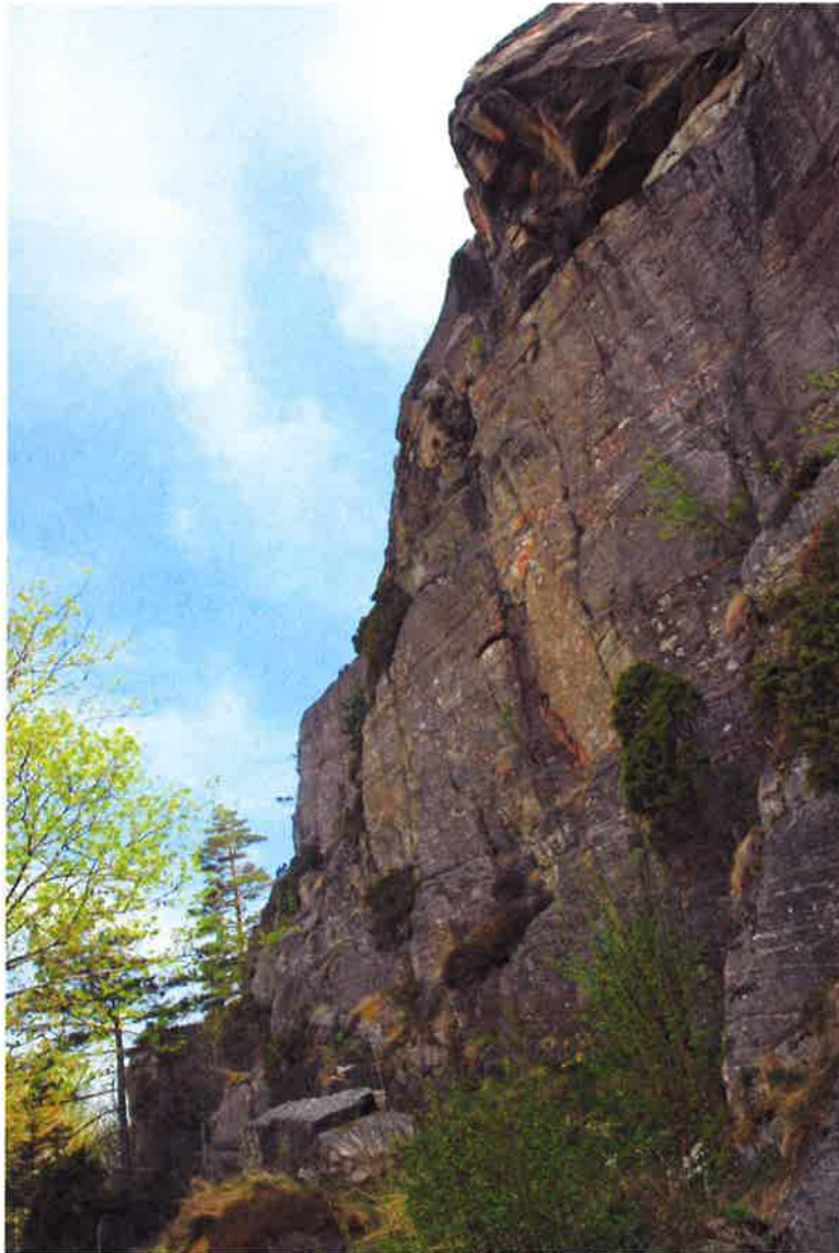
Figur 11. Lösa block vid släntfot av näst intill vertikal bergvägg med visst överhäng upptill. Fastighet 3:51, vy mot nordost (Foto ID=55).
