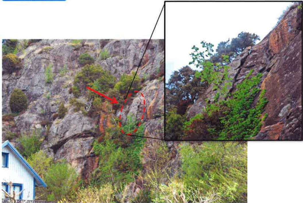
Figur 18. Fastighet 3:2. Skiva av lösgjort block ca 5 m upp i brant bergslänt. Vy mot nordost (Foto ID=27 och 29). Vid släntfoten finns skivor av lösgjorda block (se foto ID=32 och 33).
