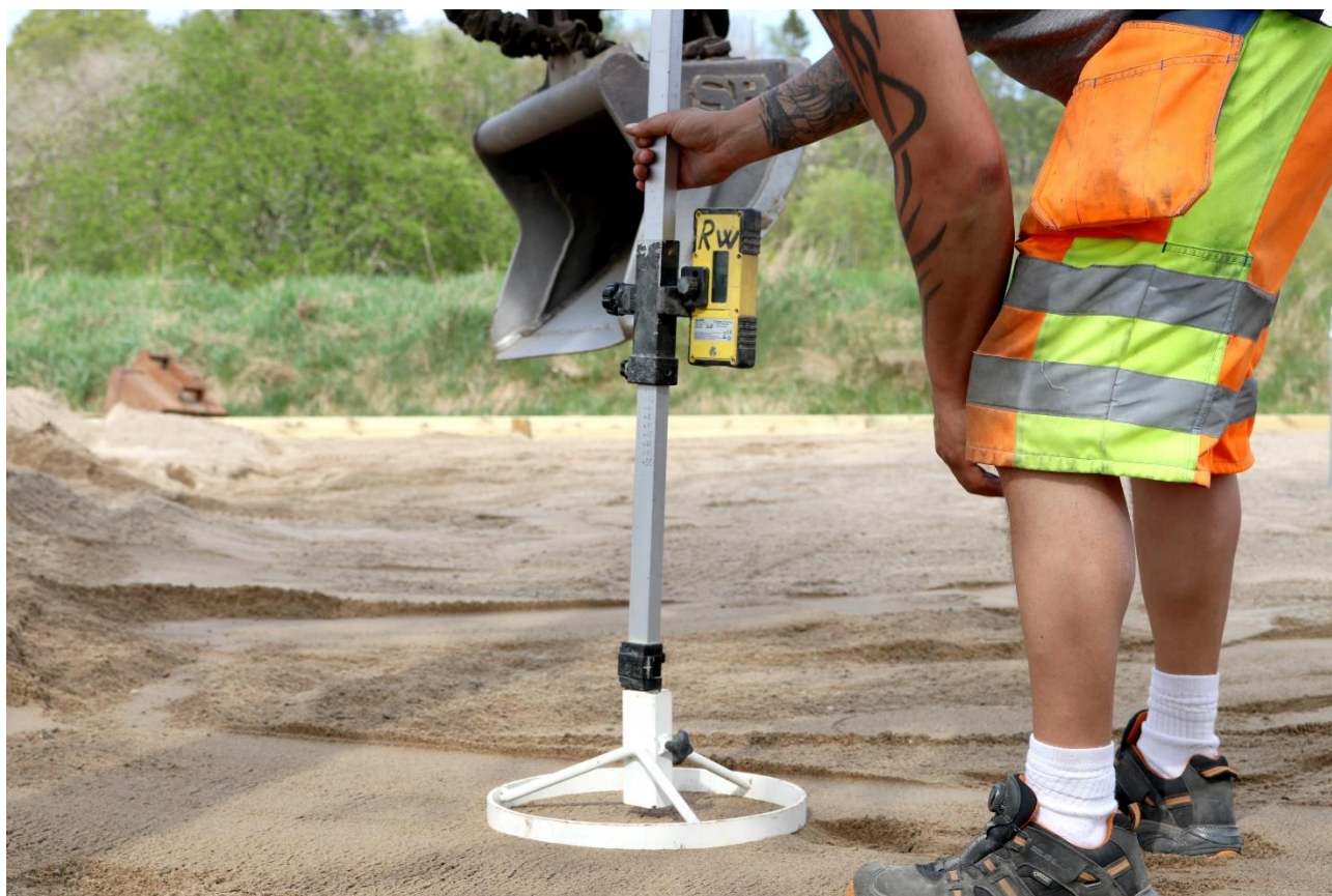
Mätpinne bygg. Foto Erland Pålsson
