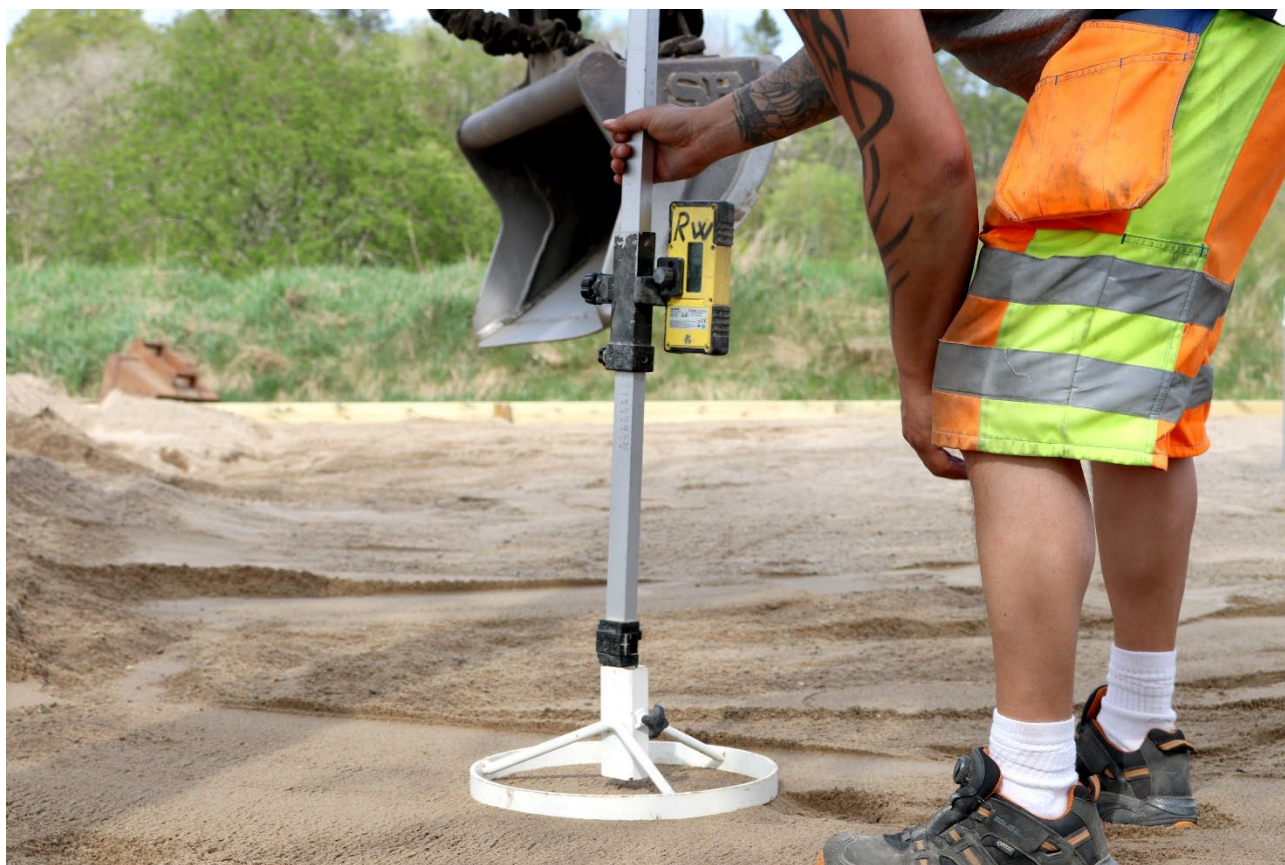
Mätpinne bygg. Foto Erland Pålsson
