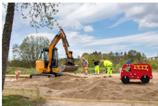
Lekplatsbygge, Hedekas. Foto: Erland Pålsson.
