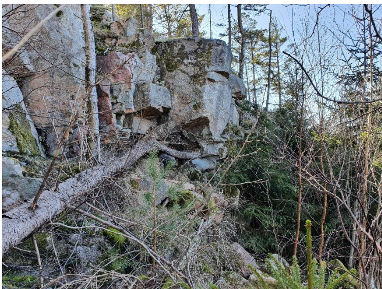
Bergslänt 4, blockuppsprucken berggrund i den norra delen av slänten. Vy mot syd.
