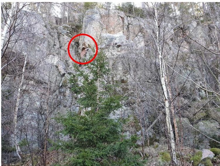
Bergslänt 3, ungefär mitt på det högsta partiet, vy mot öst. Lösa block kan ses i den höga bergslänten, alldeles till vänster om granens topp (röd ring). Blockslänt längs bildens nedre kant.
