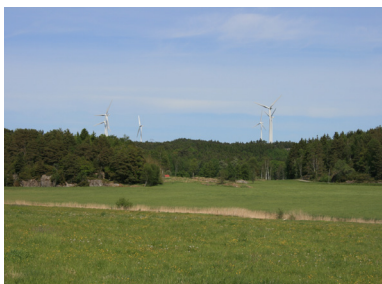
Vindkraftverk i kuperad skogsterräng vid Huds moar i Tanums kommun
