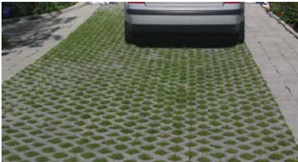
Figur 19. Genomsläpplig rasterbeläggning på parkeringsplats. (Uppsala vatten, 2014)
