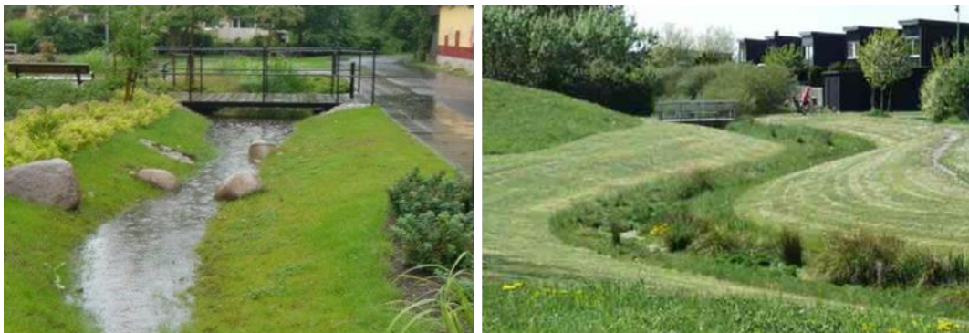
Figur 17. Augustenborg (t.v.) och Fjärilsparken, Malmö (t.h.) exempel på gräsklädda diken med flack slänthlutning (Svackdiken). (VA-SYD, 2008)
