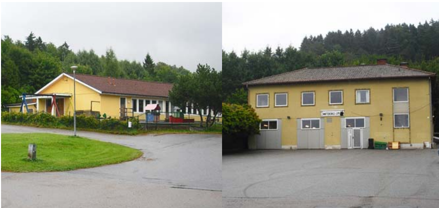
Förskolan och den gamla brandstationen återfinns inom planområdet.
