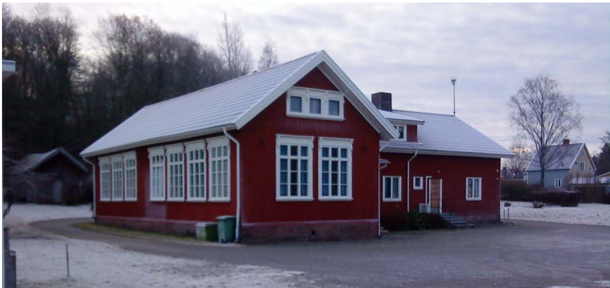
Den närmaste byggnadskroppen är den gamla skolbyggnaden med sin karaktäristiska fönsterbild m m. Den borte delen är tillbyggd senare.
