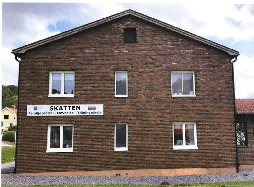
BEFINTLIG FASAD MOT SYDVÄST
